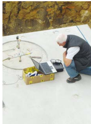
Druckluftprüfung auf Dichtigkeit
