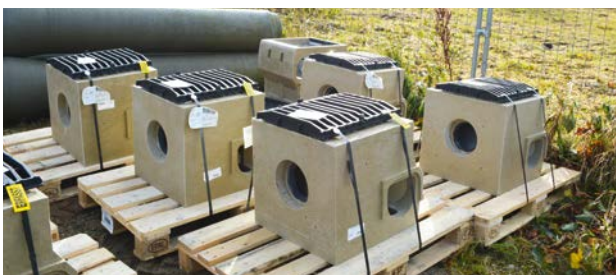
Tauchwandschächte bereit zum Einbau
