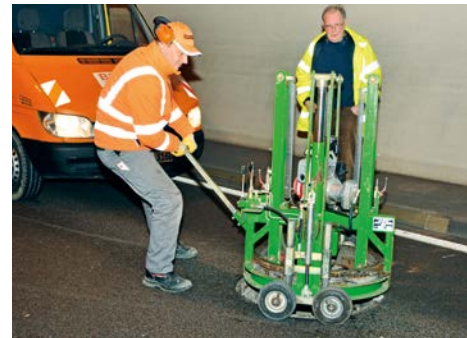
Ziehen des alten Rahmens der Schachtabdeckung
