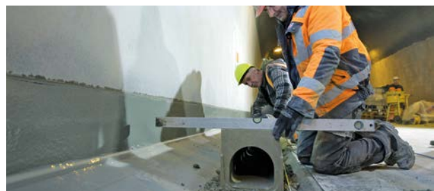
Ausrichten der Tunnelrinne, Foto: Michael Staudt
