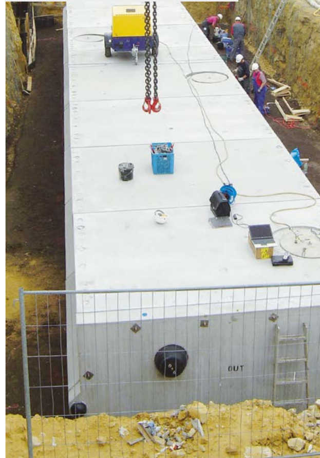
ACO Großbehälter als Havariespeicher mit Feuerlöschbehälter am Stafelter Tunnel
