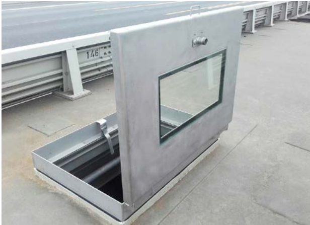
Kleiner Notausstieg mit Handöffnung
