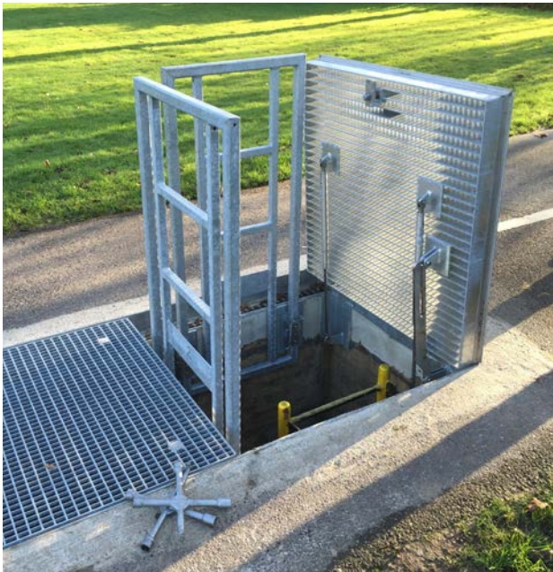
Notausstieg mit teleskopierbarem Geländer, Leverkusen
