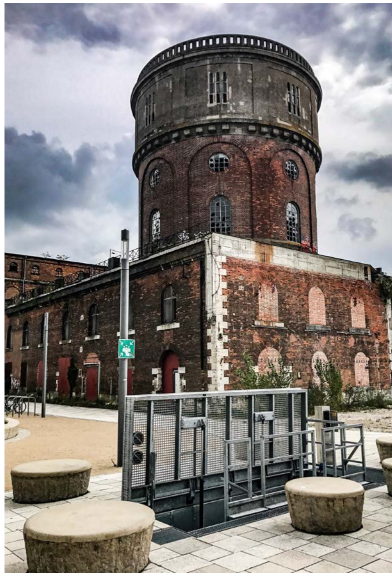
Notausstieg mit hydraulischem Antrieb als Gitterrost, Ingolstadt
