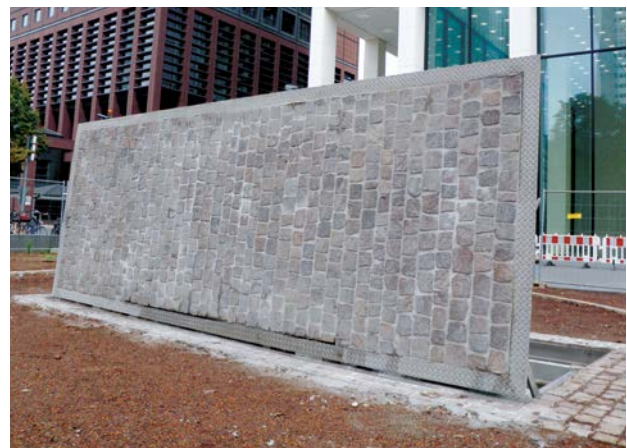
Notausstieg mit ausgepflastertem Deckel, Frankfurt
