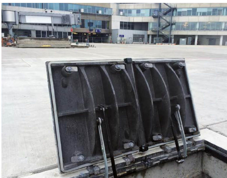
Kabelschachtabdeckung tagwasserdicht mit Stahlbetonrahmen, Klasse F 900, Frankfurt
