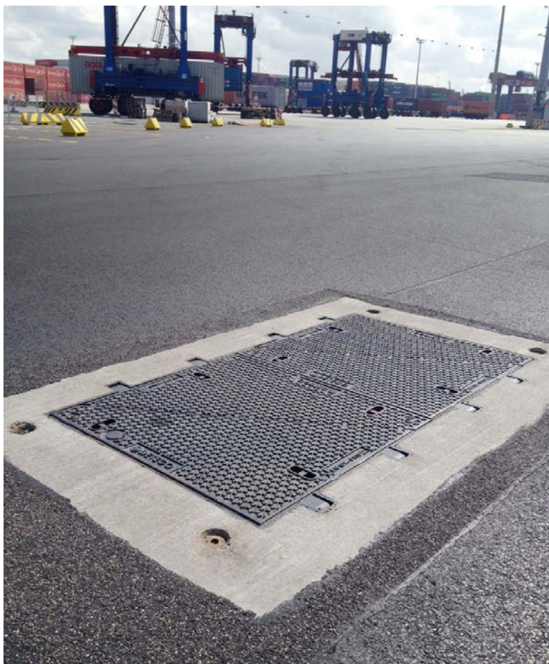
Gussabdeckungen mit Dreiecksdeckeln und Fertigteilrahmen, Klasse F 900
