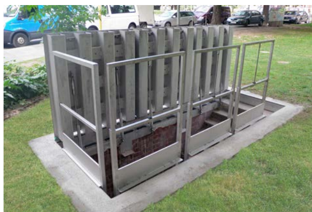
Dreiteilige Abdeckung mit Öffnungshilfe und Klappgeländer, Frankfurt
