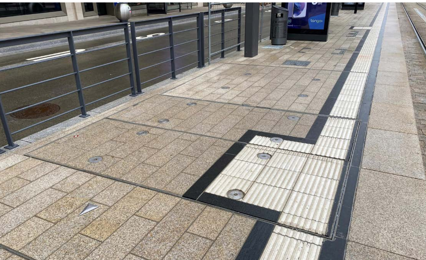
Unauffällig, so wenig Metall an der Oberfläche wie möglich – umsetzbar mit auspflasterbaren Bodentoren, Luxemburg
