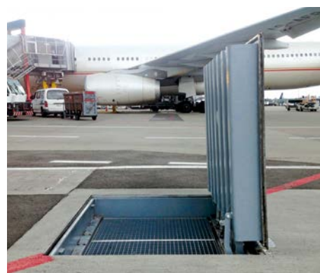
Zugangs- und Montageöffnung, Klasse F 900
