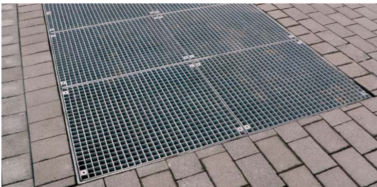
6-teilige Gitterrostabdeckung, Frankfurt
