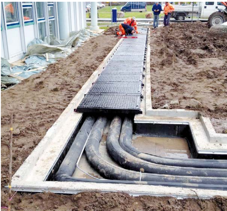
Reihenabdeckung aus Guss, Klasse B 125, Heidelberg
