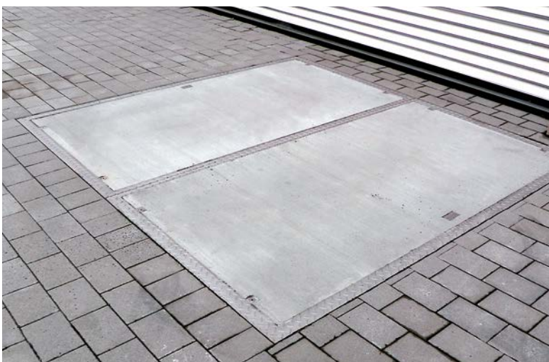
2-teilige Schachtabdeckung mit Betonoberfläche, Frankfurt
