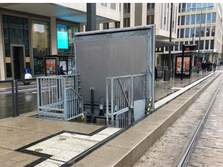
LKW-befahrbare, tagwasserdichte, hydraulische Trafoabdeckungen mit Wärmedämmung, Luxemburg
