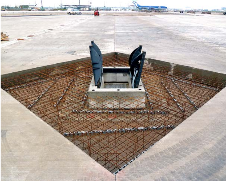
Kabelschachtabdeckung mit Dreiecksdeckeln als Fertigteil mit höhenverstellbarem Stahlbetonrahmen, Klasse F 900, Frankfurt
