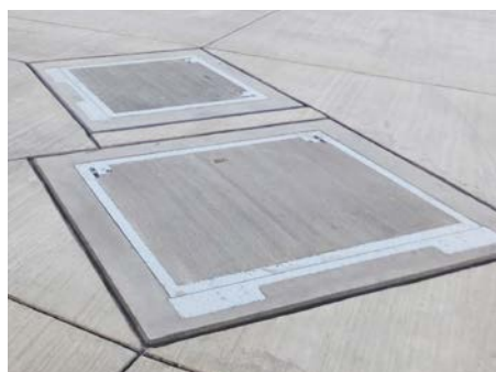
Sonderschachtabdeckungen mit Schutz vor Rückstau oder Überflutung
