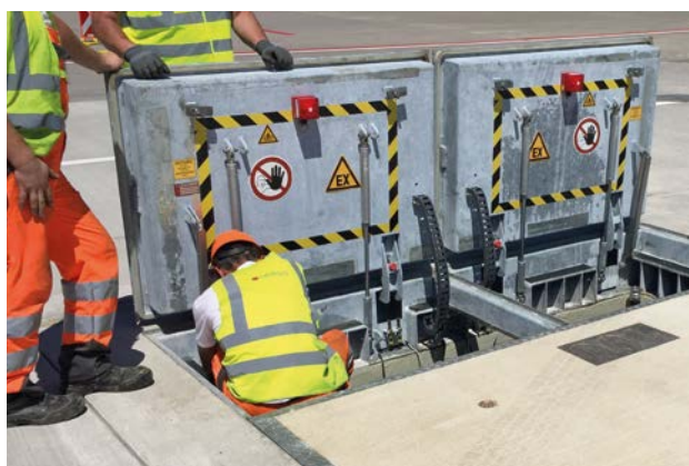
Schwerlastabdeckung mit zwei Revisionsöffnungen, Klasse F 900
