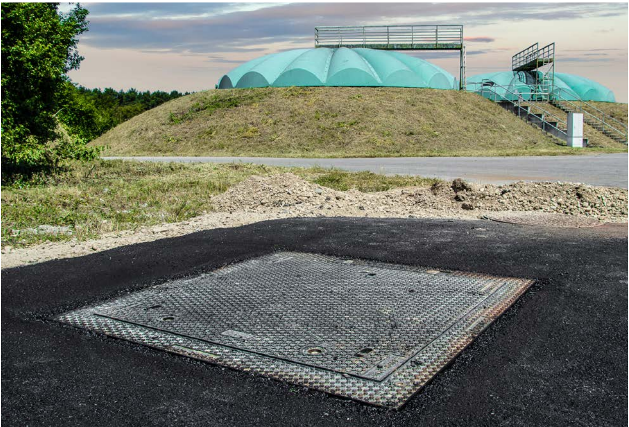
Gussabdeckung tagwasserdicht, Klasse D 400, München
