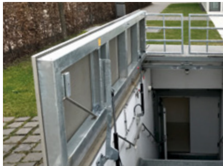
Großformatige, rechteckige Abdeckungen auf Bauwerksöffnungen
