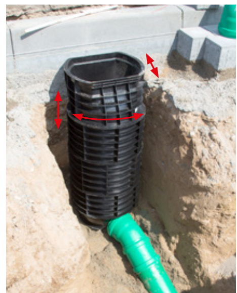
höhenverstellbar, drehbar, neigbar
