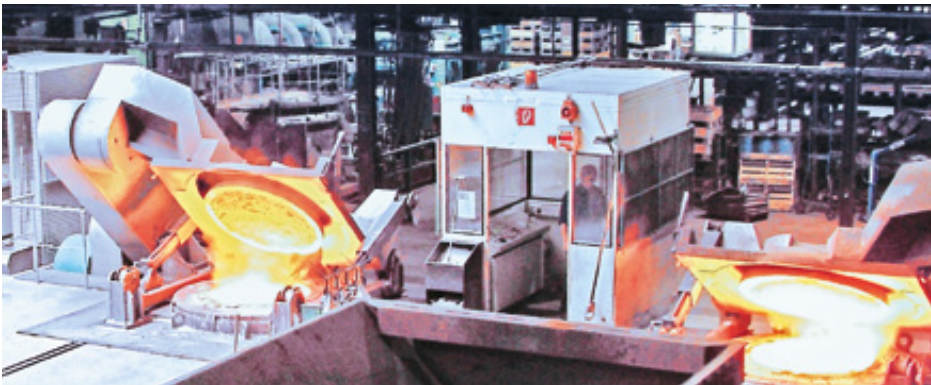
Moderne Mittelfrequenz-Induktions-Schmelzöfen, ACO Kaiserslautern
