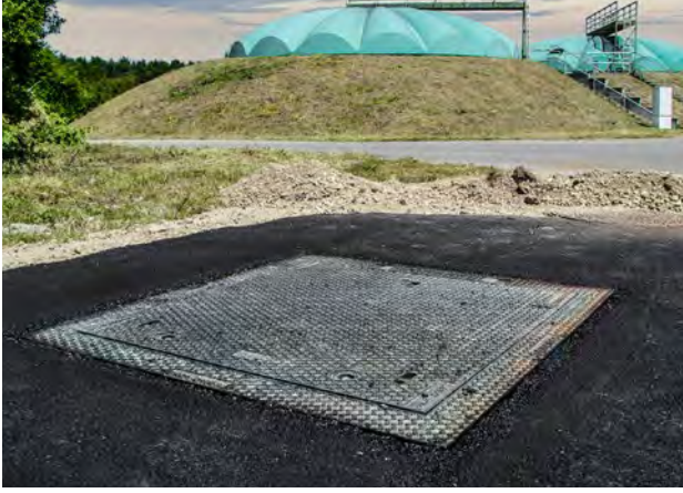
Gussabdeckung tagwasserdicht mit Öffnungshilfe, München
