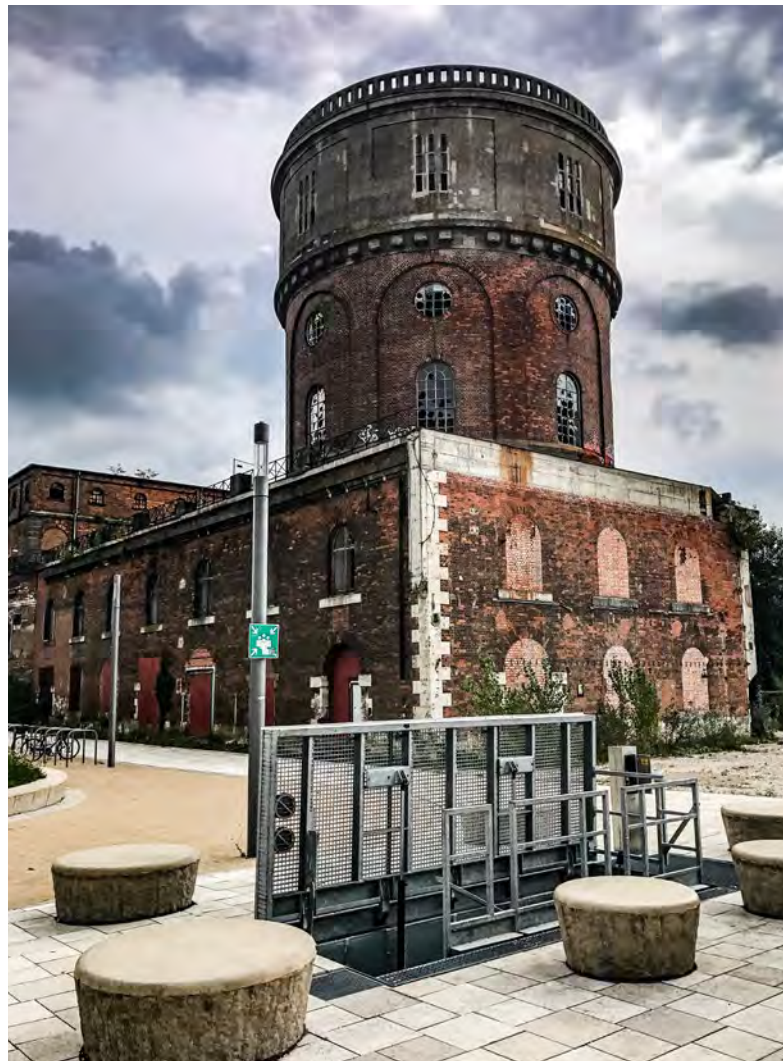
Notausstieg mit hydraulischem Antrieb als Gitterrost, Ingolstadt
