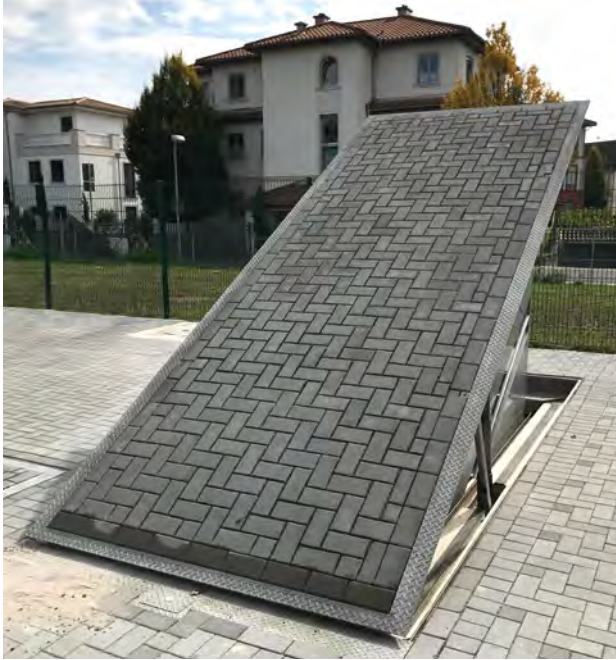
Einstieg in Pumpwerk, Seligenstadt
