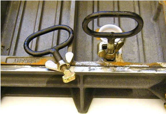
Bei Ausheben des Deckels mit Kranhilfe dürfen nur die Aushebegriffe verwendet werden. Sie müssen festgeschraubt sein. Die Deckel sind vor dem Anheben mit dem Kran mittels Aushebewerkzeug zu lockern. Einzelne Deckel können in der Reihenabdeckung beliebig geöffnet werden, es ist dafür nicht erforderlich alle Deckel der Abdeckung zu entfernen.
