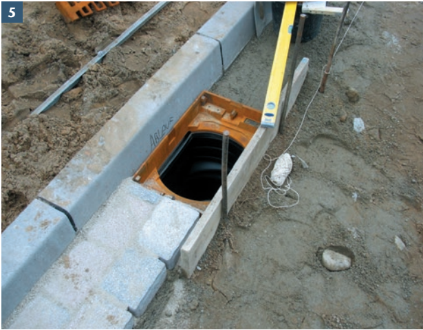
Anarbeiten der seitlich angrenzenden Oberflächenbeläge gem. ZTV
