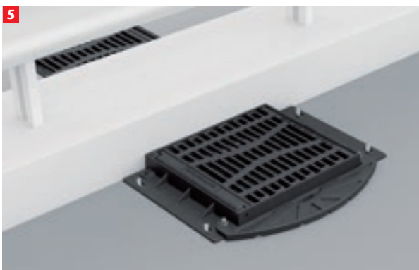
5 Setzen des Sanieraufsatzes
