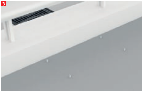
3 Verlegen der Dichtbahn
