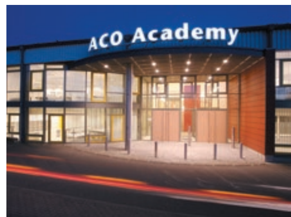
Die ACO Academy in Büdelsdorf/Rendsburg
