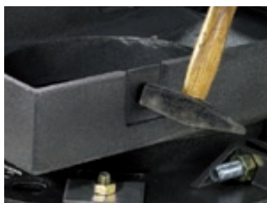
Aufschlagen der Bauzeitentwässerung
